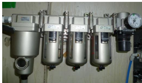
Filtros de aire que constituyen las unidades de mantenimiento.
