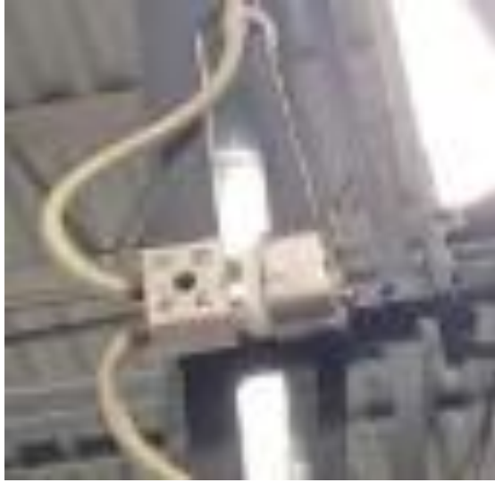
EJEMPLO: Conector hembra dañado.
